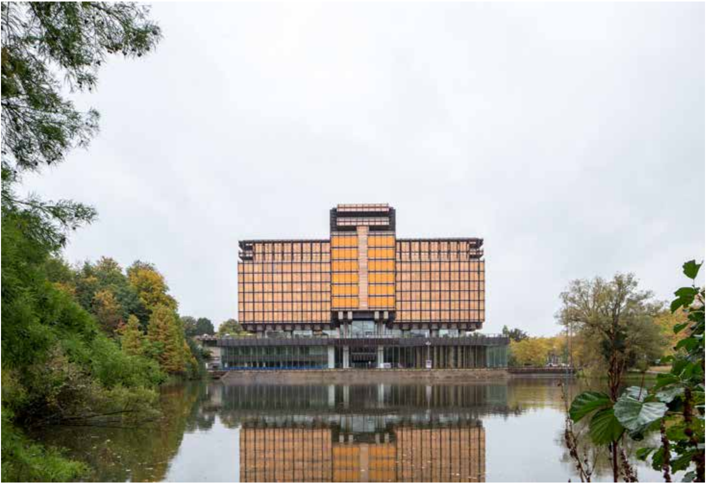
Bestaand gebouw © Séverin Malaud
